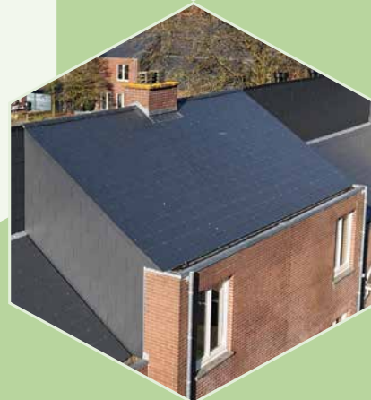
Foto's: Dakrenovaties Kerkhovenakkerlaan / Van Ostaeyenlaan
